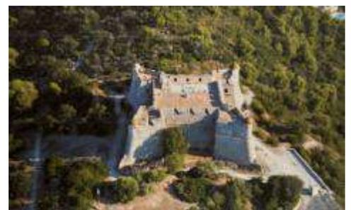
La principale caractéristique du « tracé à l'italienne » est l'ajout de bastions : ces ouvrages en saillie permettent des feux croisés ne laissant à l'ennemi aucun espace protégé. Ils permettent les tirs en enfilade. En balayant les assaillants parvenus au pied de la courtine, les bastions empêchent les mineurs de s'attaquer aux murailles.
