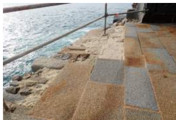
Marche de plus d'une tonne soulevée et emportée, dallage arraché, passerelle déformée.....
