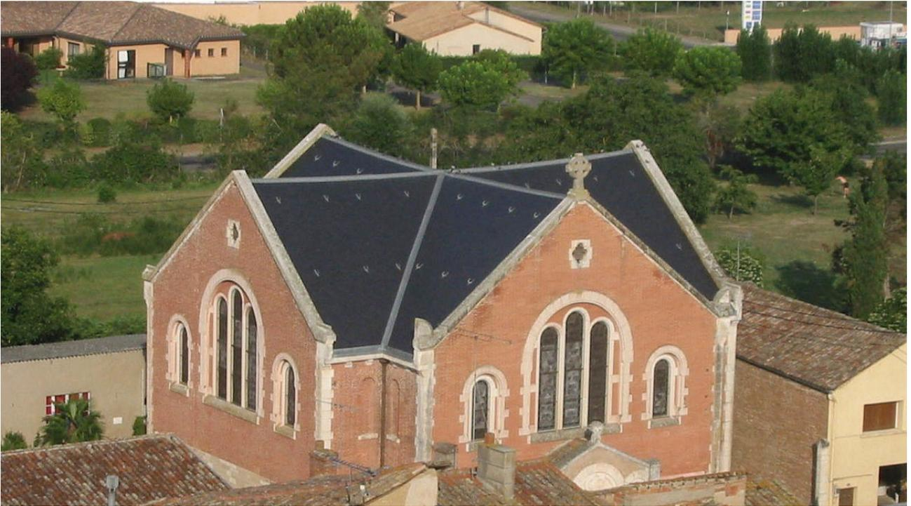
"Le temple a été construit par Jules Bourdais vers 1868. Il adopte un plan carré à angles rentrants. L'édifice réalise la solution d'avant-garde préconisée par Viollet-le-Duc grâce à la fonte et surtout à la poutrelle métallique et au béton armé.
